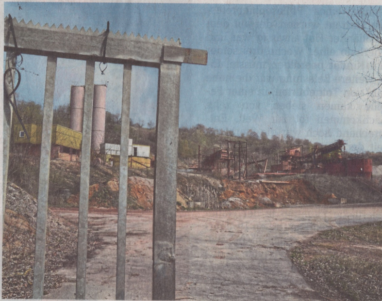
Von der ehemaligen Brechanlage Rümmelsheim III an der nach Waldalgesheim führenden Kreisstraße, ist nach dem Rückbau jetzt so gut wie nichts mehr zu sehen.
